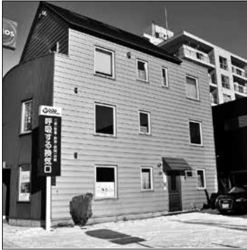
本社事務所もあるグッドマン・ショールーム
