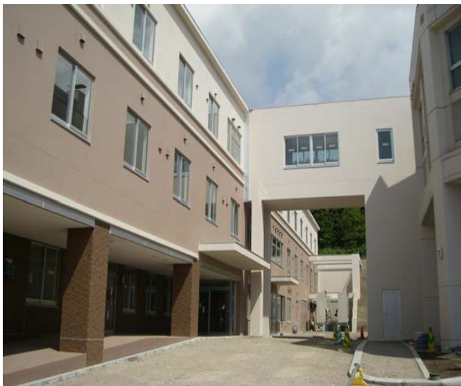
増築にて各居室 グッドマン換気口 GMS-100P 106組
