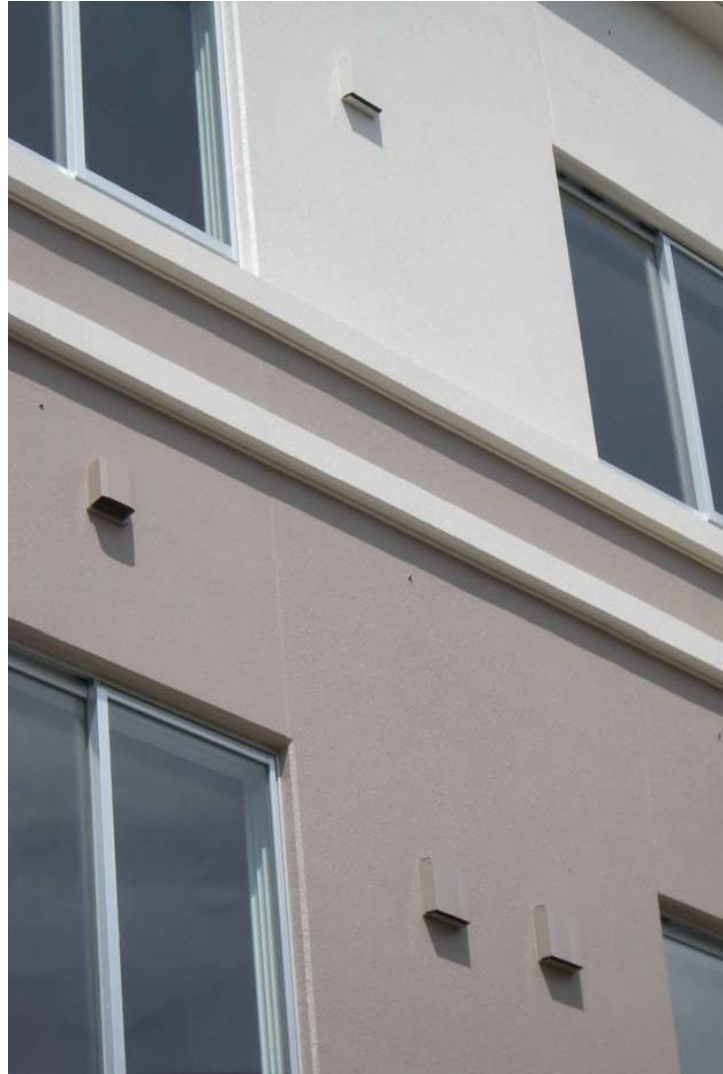
増築にて各居室 グッドマン換気口 GMS-100P 106組
