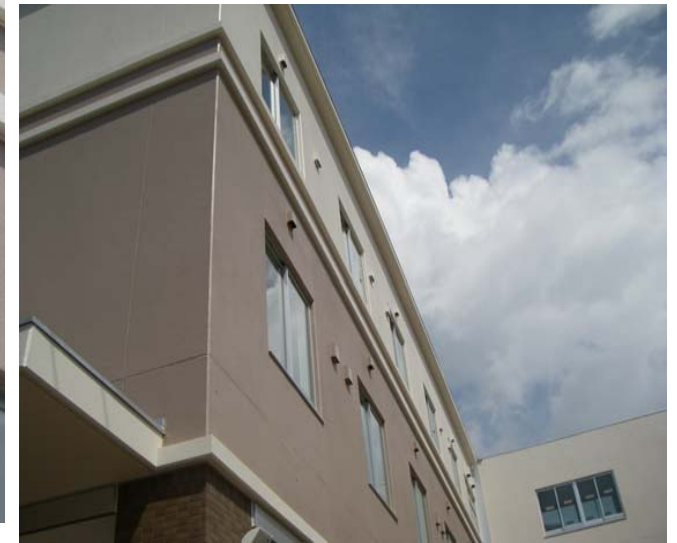
増築にて各居室 グッドマン換気口 GMS-100P 106組
