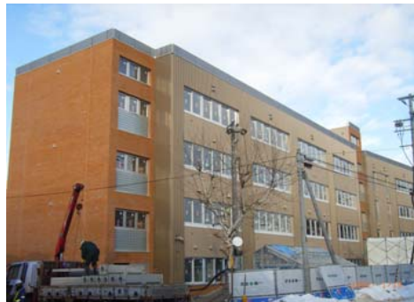
札幌市内 信濃小学校 建設中
