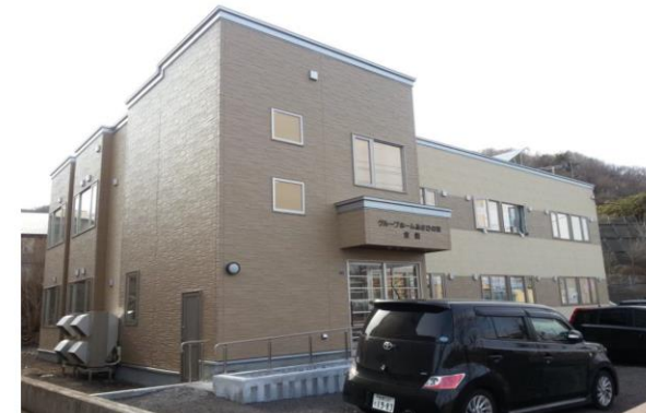
室蘭市内 老健施設 新築
