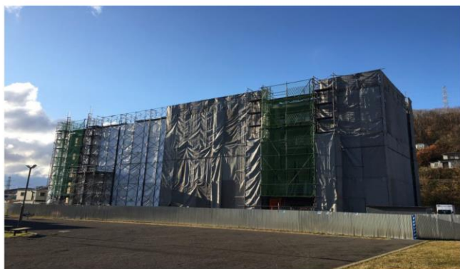
室蘭市 道営住宅 新築 B棟建設中
