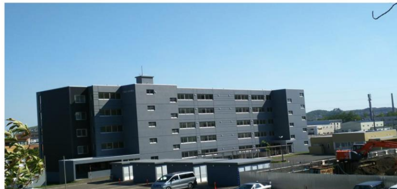
室蘭市 道営住宅 新築 A棟
